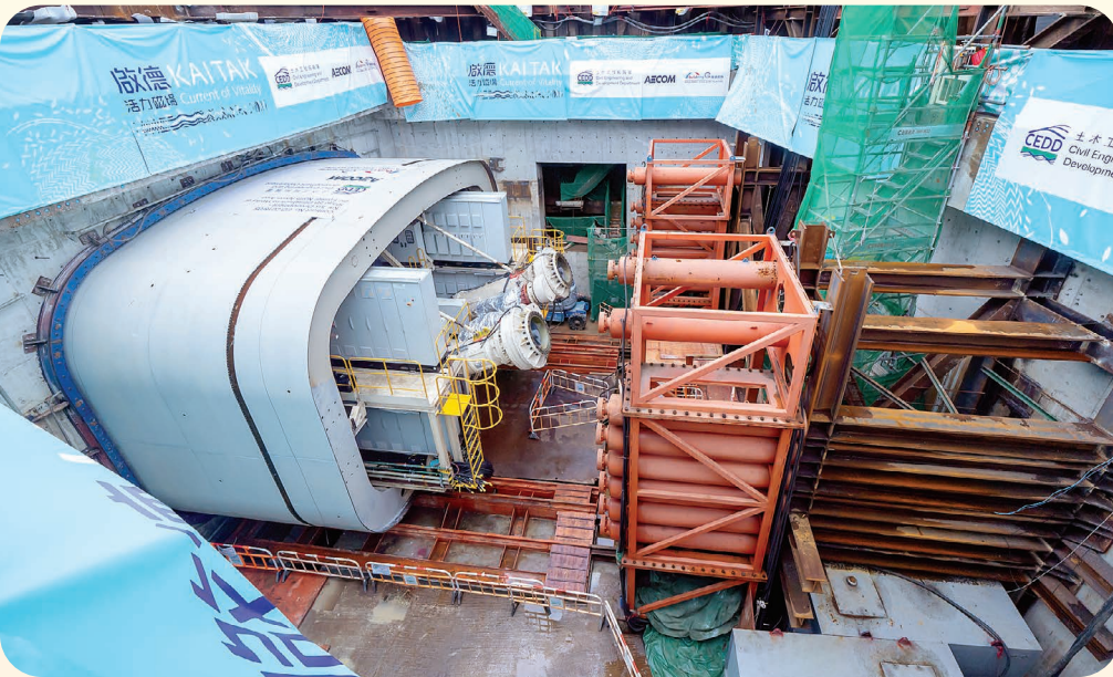
裝嵌矩形隧道鑽挖機鑽頭 RTBM Head Assembly
